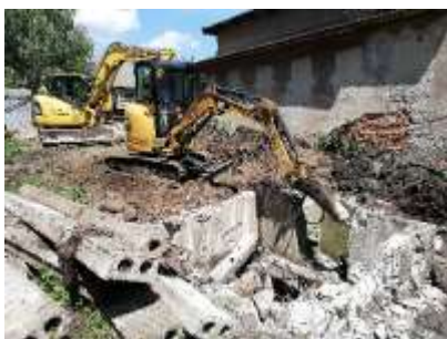
Bourání nadzemní části odlučovače ropných látek
