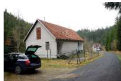
Objekt úpravny vody Cípková při předání staveniště zhotoviteli před zahájením prací
