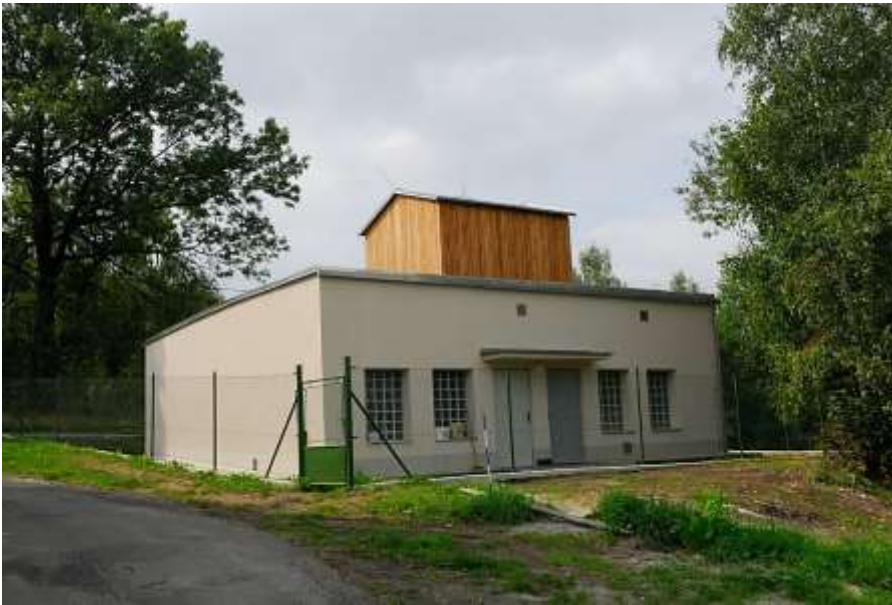
Vodohojem Adámky po ukončení prací
