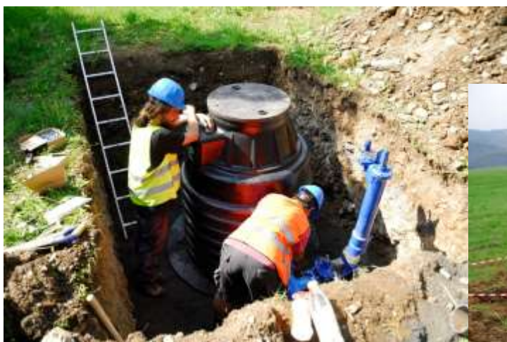
Práce na sekčních ventilech vodovodního řadu v obci Prostřední Bečva
