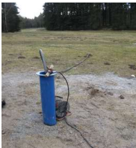
Čerpací zkouška nového zdroje pitné vody pro vodovod Sázava
