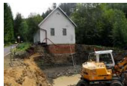
Příprava stavební jámy pro nově usazované prefabrikáty vodojemu Cípková
