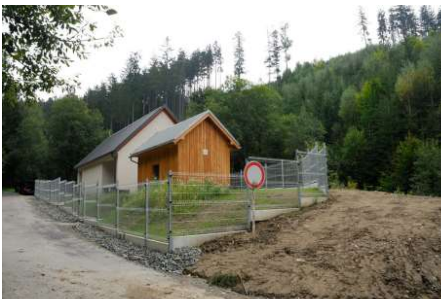
Objekty vodojemu a úpravny vody Cípková po dokončení prací
