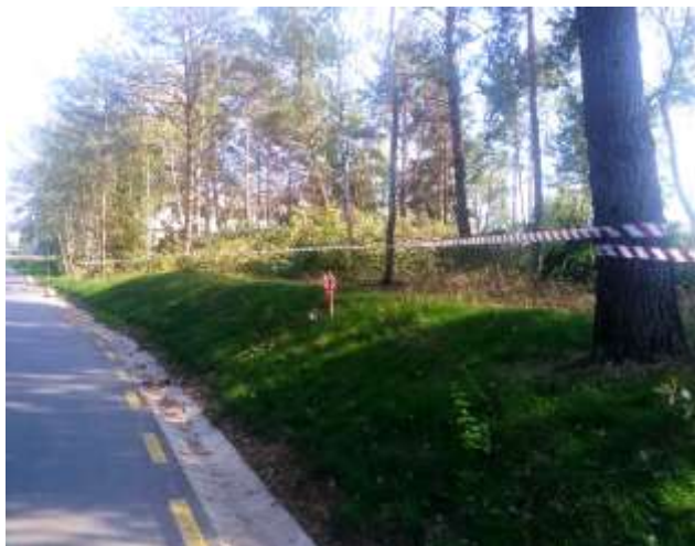
Říjen 2018 – stav před zahájením sanačních prací
