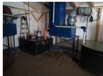
Část sanační technologie
