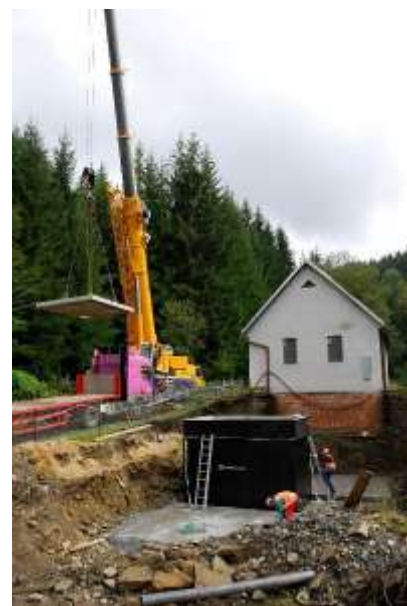
Sestavování prefabrikovaného vodojemu
