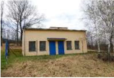
Původní stav vodojemu Adámky
