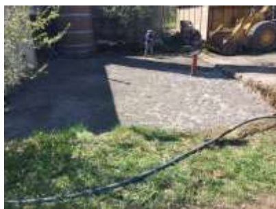
Příprava zpevněné plochy pod sanační technologií
