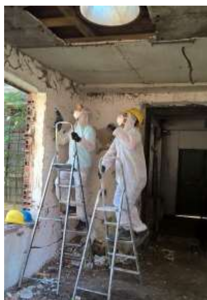
Odstraňování azbestových desek z pohledu odmašťovny
