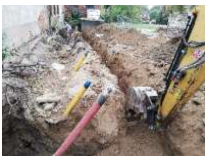
Budování výkopů pro potrubí a kabeláž, vlevo šikmé ventingové vrtvy
