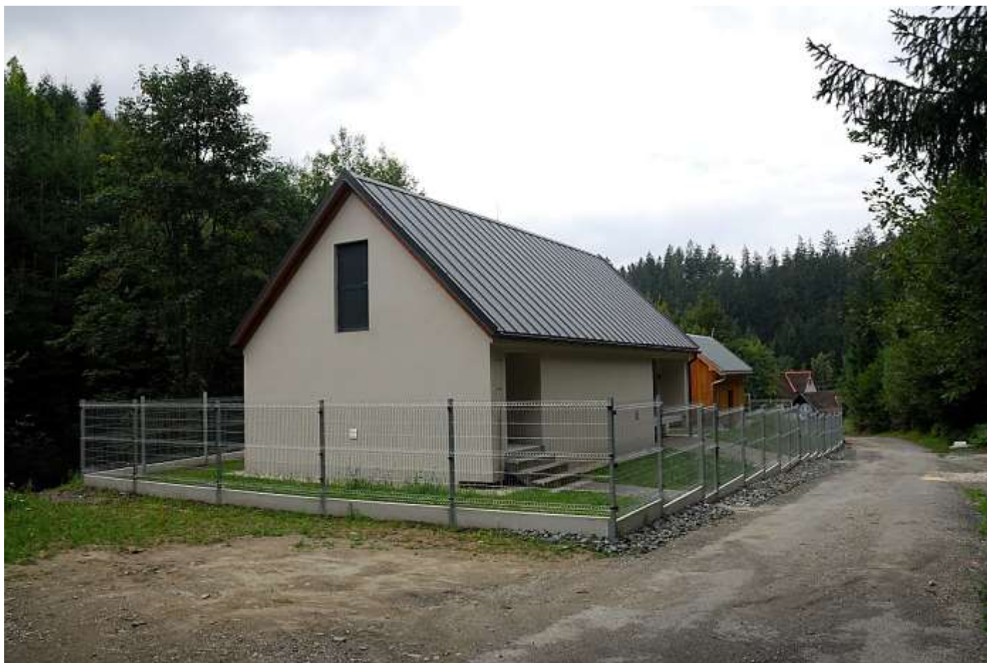
Objekt úpravný vody Čípková po ukončení prací
