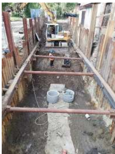
Sanační výkop - zavážení, hutnění, osazení šachty na kanalizaci
