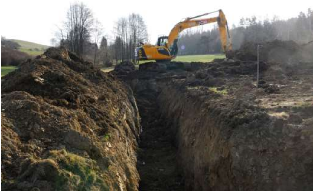
Budování jímacího zářezu v Přečovicích
