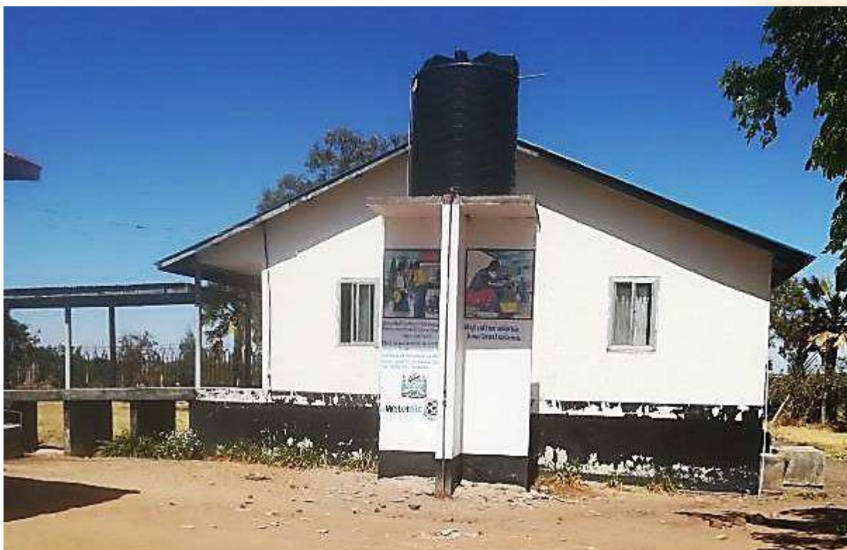
Zásobník vody (PE nádrž na vodu)
