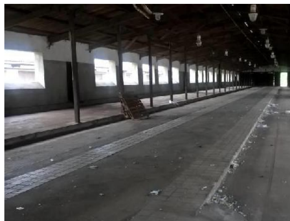
Obr. 14: Hala D kompletně zbavená odpadů
