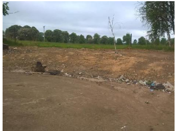
Obr. 26: Západní část sektoru CH po kompletním vymístění odpadů
