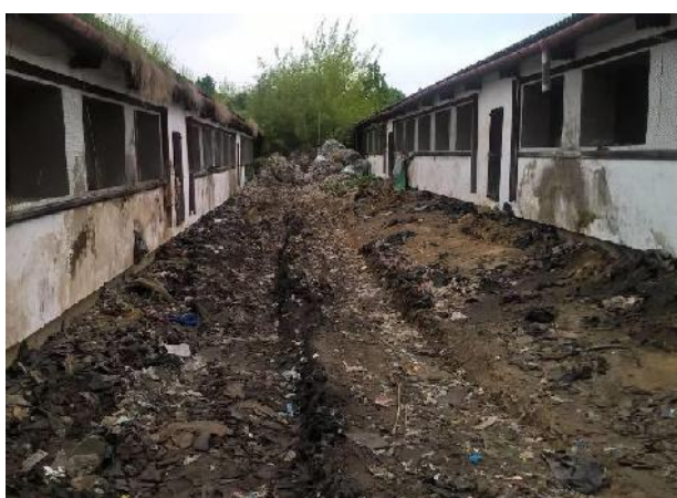
Obr. 23: Meziprostor A-B po částečném vymístění plastů, meziprostor D-E po odstranění odpadu
