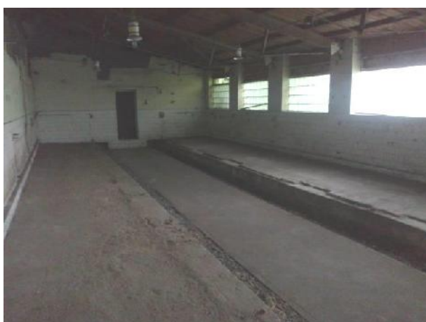
Obr. 15: Hala F kompletně zbavená odpadů
