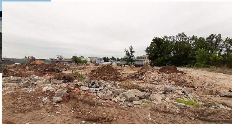
Po demolici - kopané sondy pro odběr vzoků
