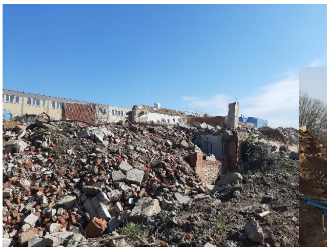
Demolice podzemních konstrukcí
