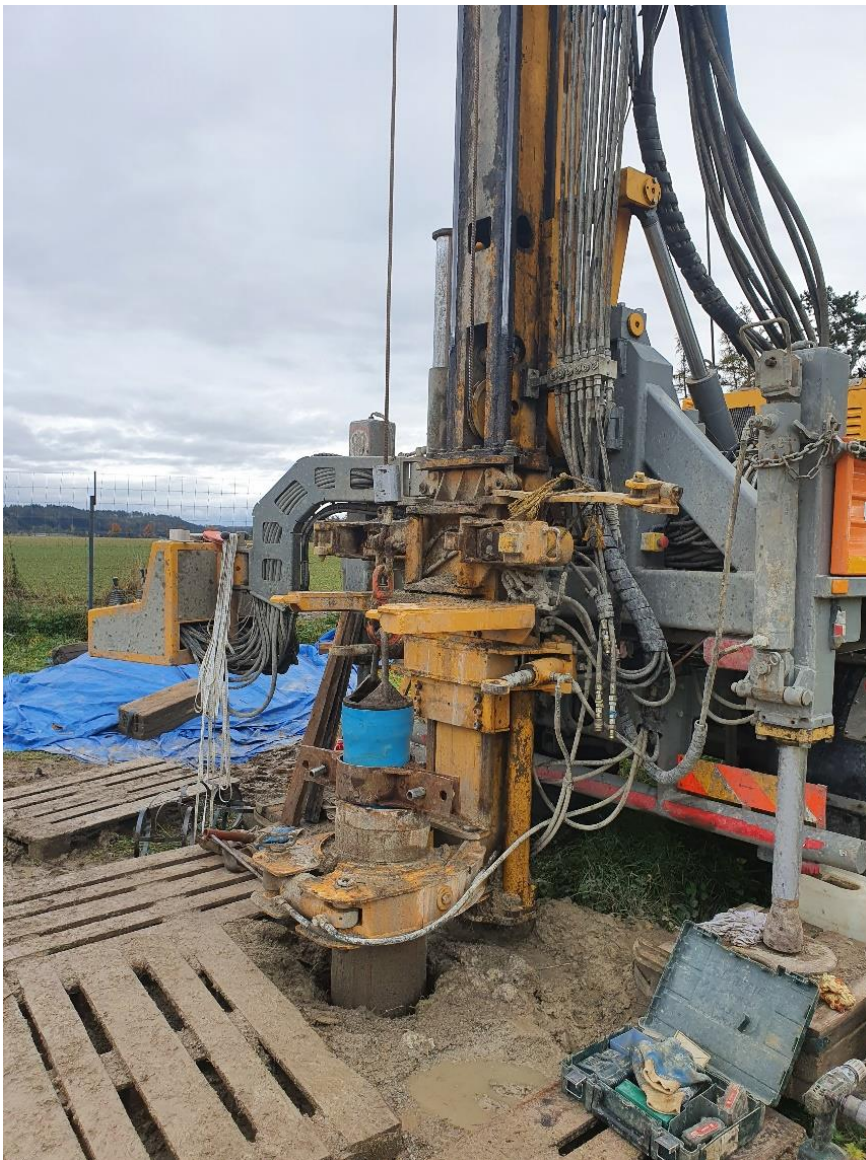
Vrtná souprava při vystrojování
