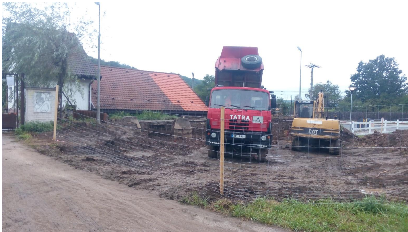
Odtěžba navážky v místě nově navržené dosazovací nádrže
