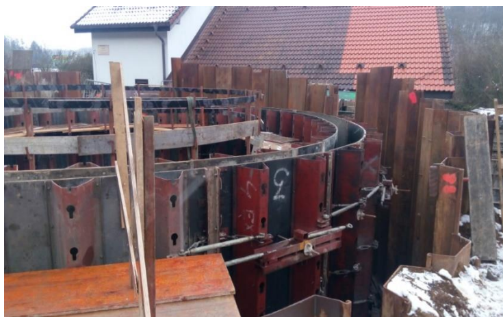
Kruhové bednění dosazovací nádrže
