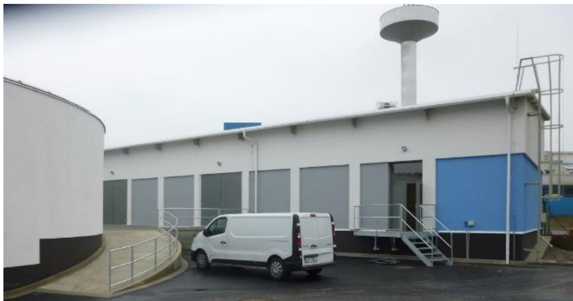
Budova BČOV a ÚV, vlevo vodojem
