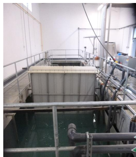
Spouštění MBR modulů do BČOV
