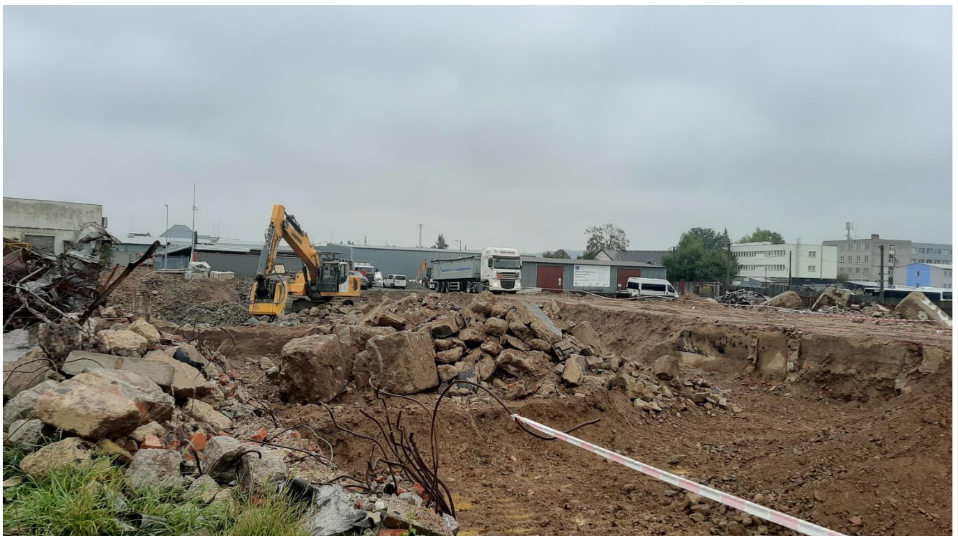
Odtěžba podzemních konstrukcí a zemin
