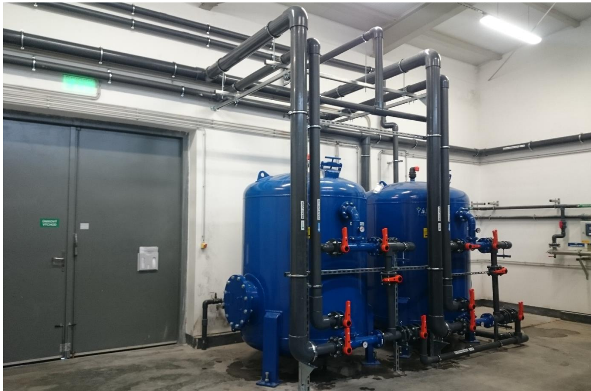
Filtrace dešťových vod
