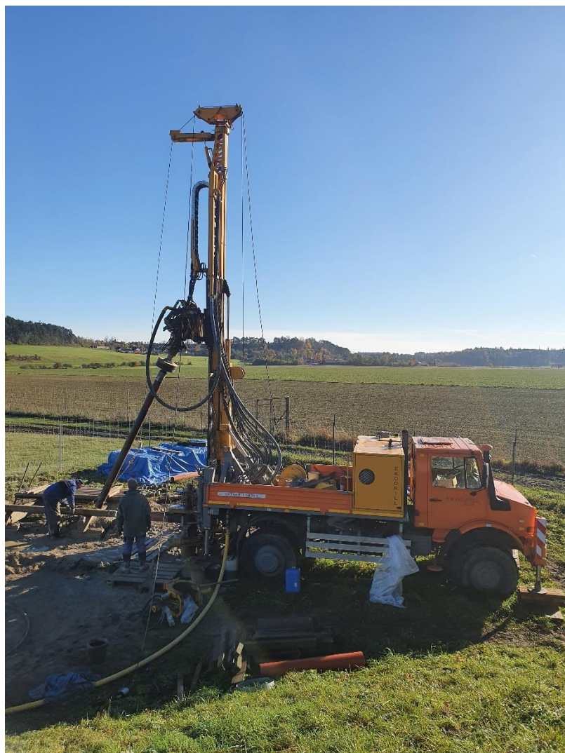
Vrtná souprava na lokalitě
