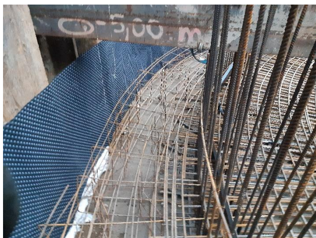
Výztuž protivztlakové pojistky dosazovací nádrže
