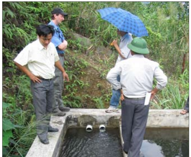
Obr. 4: Kontrola technického stavu rezervoáru pitné vody
