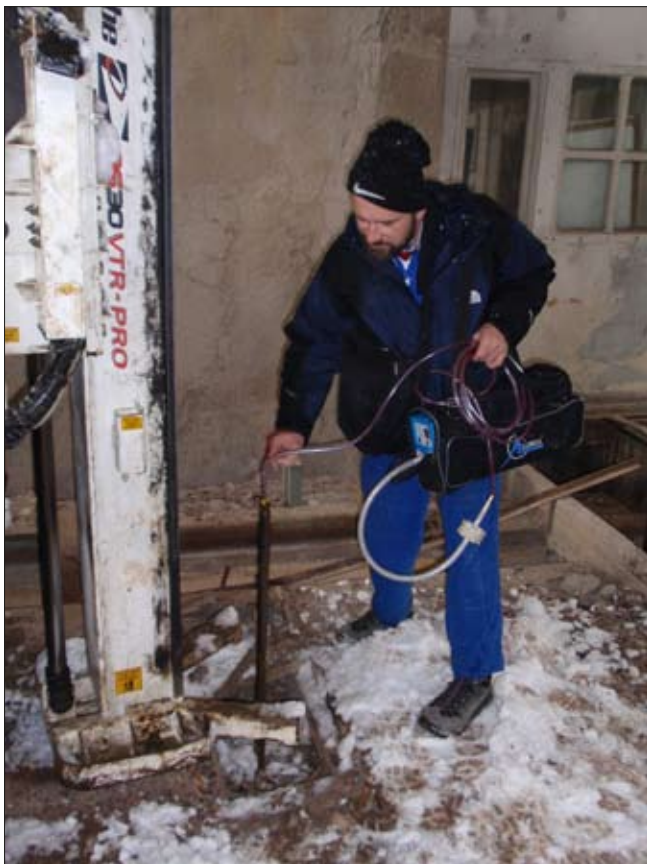
Obr. 23: Terénní měření rtuť v půdním vzduchu v budově bývalé elektrolyzy
