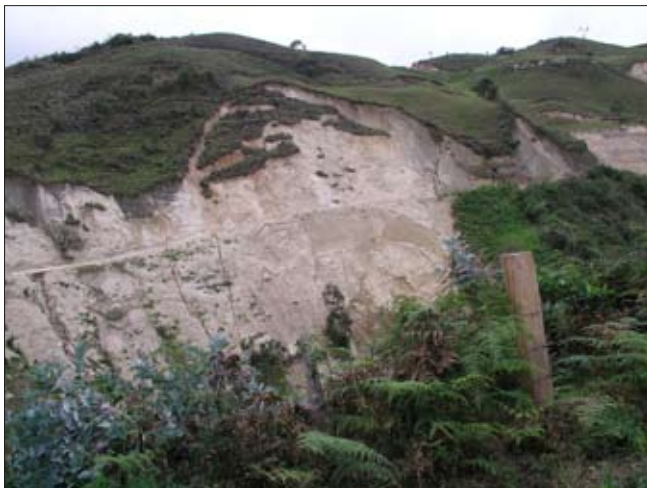
Obr. 39: Sesuvy zvětralin v trase vodovodu
