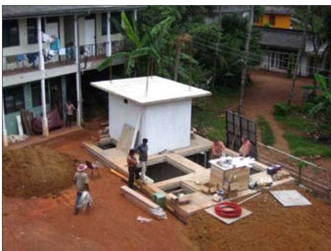
Obr. 36: Kompletně dokončená stavba připravená pro instalaci technologie
