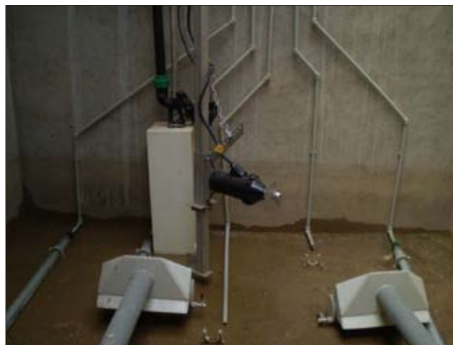
Obr. 37: Instalovaná technologie v reaktoru ČOV Monoblok – T 350 EO
