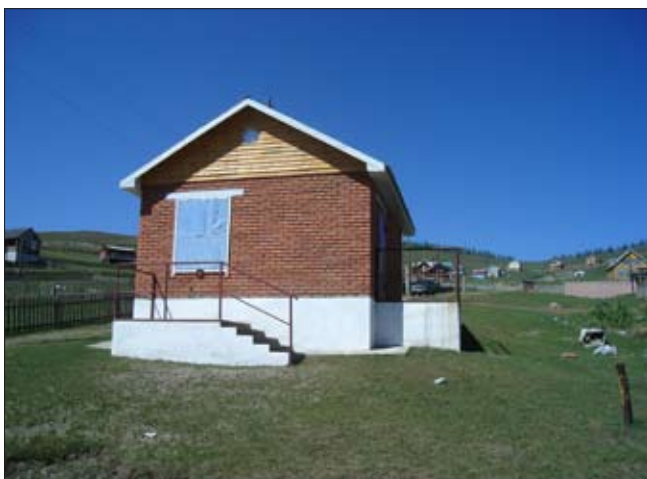
Obr. 31: Stavební zabezpečení vrtů
