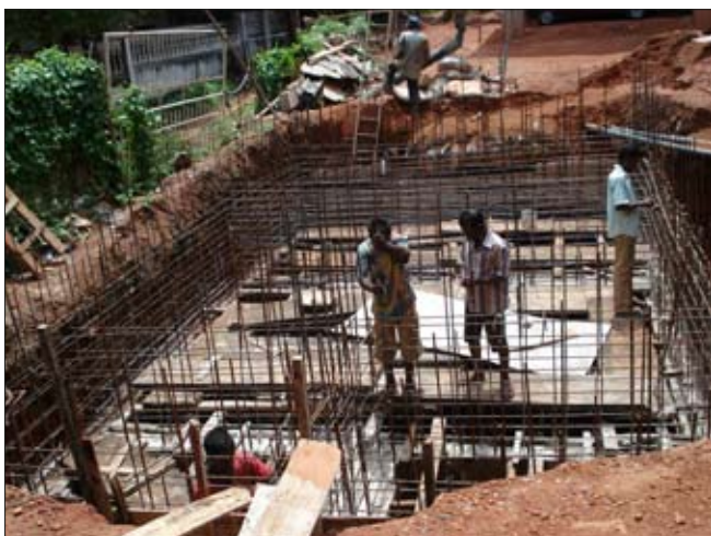
Obr. 35: Průběh stavebních prací na ČOV v nemocnici Pannipitiya
