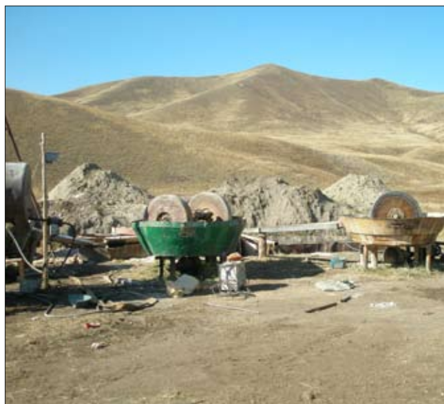
Obr. 29: Nově instalovaná úpravna s kolovými mlýny na lokalitě Oktjabr, v pozadí odpady po amalgamací
